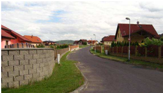
Obr. 2 Jenišov – suburbanizace (foto Zdeňka Lipovská)
