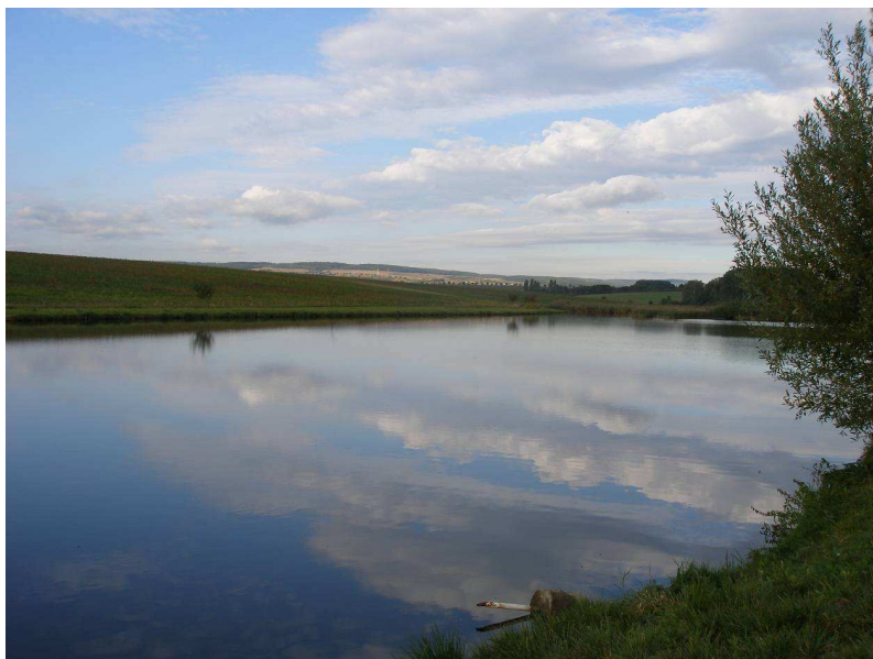
Obr.č.2 Akumulační nádrž
