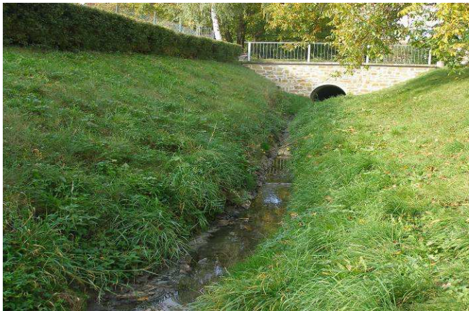
Obr.č.4 Výust' kanalizace
