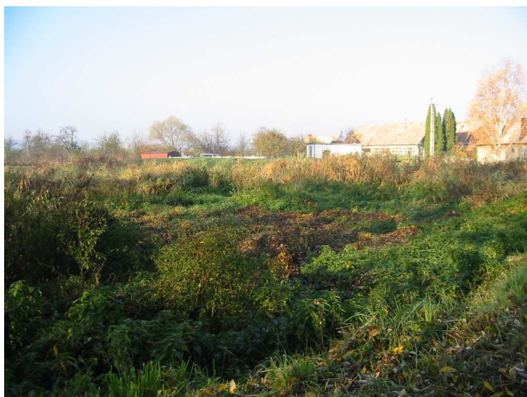
Obr. 1: Poškodené pole „A“ čistiarne Hontianske Moravce – fotografia zhotovená na mieste
