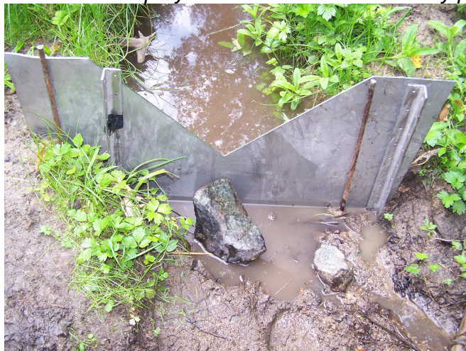
Obr. č. 4: Ocelové opěry sloužící ke stabilizaci masky přelivu
