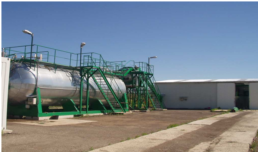
Obr. 2 Pilotní zařízení anaerobní fermentace v Brně Černovicích, ÚVP Brno
