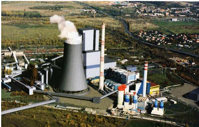
Obr. 2 snímek ELE po výstavbě NZ 660 MW
