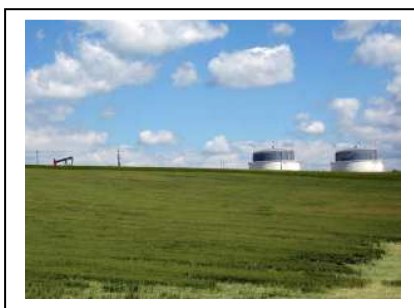
Obr. č. 2 Zásobníky ropy Dambořice
