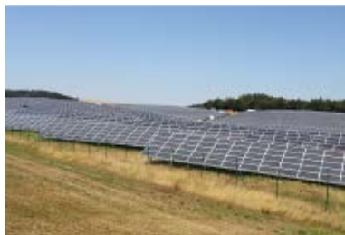
Fig. 1 The photovoltaic power station Vranovská Ves (Photo: Doskočilová)
